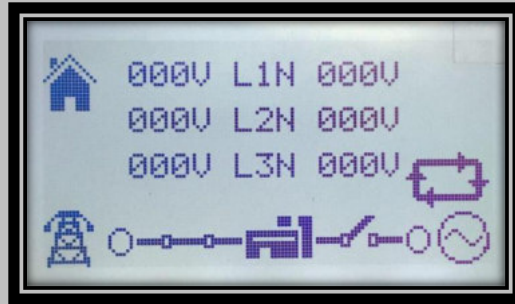
Generator & Mains Voltage (L-N)
